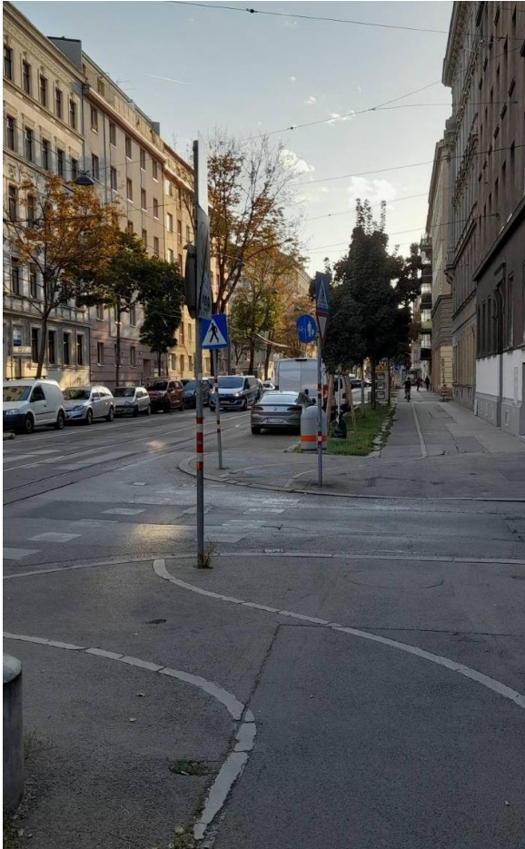
Bild 2: Die Querung der Siebertgasse in der Flurschützstraße in Richtung stadtauswärts schränkt den Radverkehr durch den Kurvenverlauf aktuell ein. Eine Begradigung würde bequemes und flüssiges Vorwärtskommen im Sinne einer Radbasisstrecke deutlich erleichtern.
