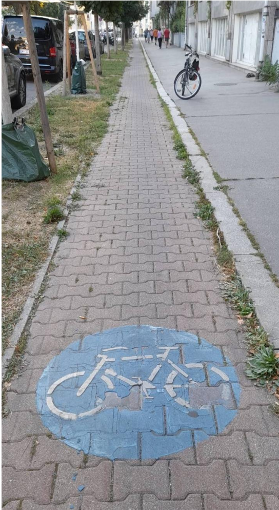
Bild 3: Hier am Beispiel der Radfahranlage in der Flurschützstraße in Richtung stadtauswärts: Die Radfahranlage ist gerade so breit, dass sich ein Piktogramm ausgeht. Überholen ist über weite Strecken nur sehr schwer möglich. Auch der erneuerungsbedürftige Belag dieser Radbasisstrecke ist hier deutlich zu erkennen.
