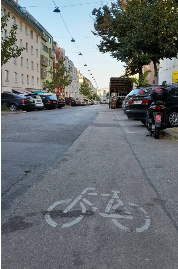
Bild 1: Beginn der Radbasisstrecke mit Priorität 1(!) in der Wilhelmstraße Richtung stadteinwärts
